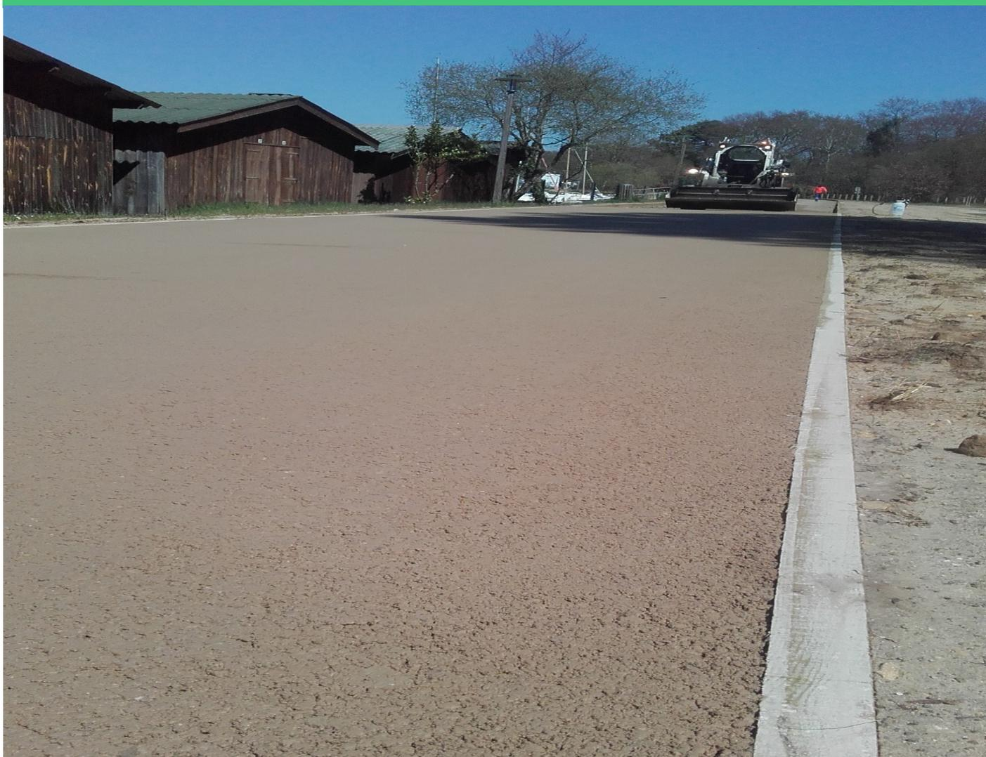
Compaxem® est un sable ou un micro béton compacté (revêtement stabilisé renforcé) fabriqué à base du liant écologique Compaxem® d' **argeco**
